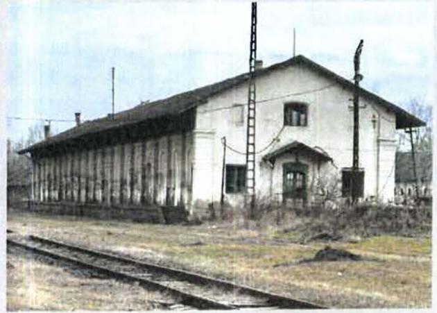
26. Az indóház raktárépület felújítás előtt MJSZ: 10856
