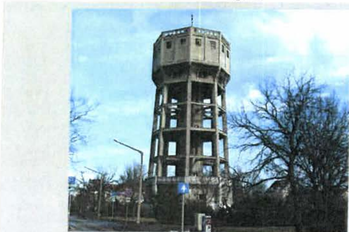
29. Eötvös téri víztorony MJSZ: 11558
